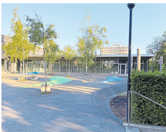
Blick auf die Turnhalle, in der sich der Materialraum befindet. Er wird nun zum Schulzimmer erweitert. Bild: Nathalie Wolgensinger
